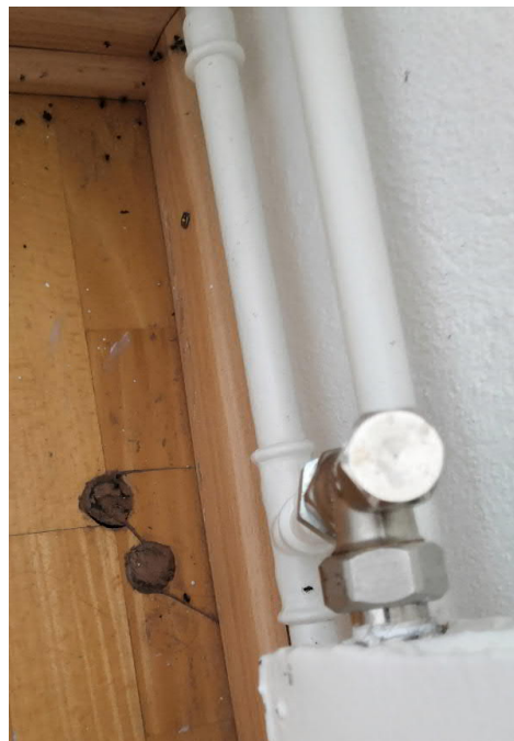
Kuva 6. Lämmityspatteri ja termostaattinen patteriventtiili. Oikealla näkyvissä vanhat ja tulpatut lämmityspattereiden kytkentäjohtojen läpivientipaikat lattiapinnassa.
