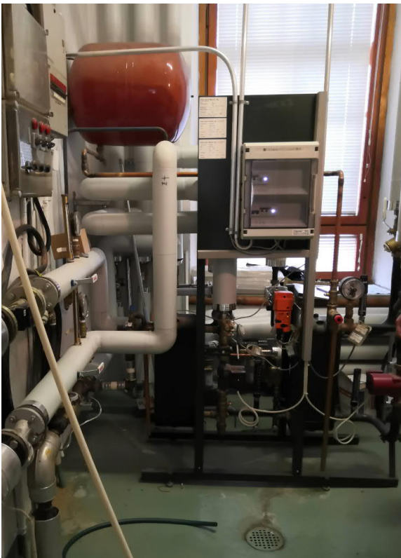
Kuva 5. Lämmönjakokeskus.
