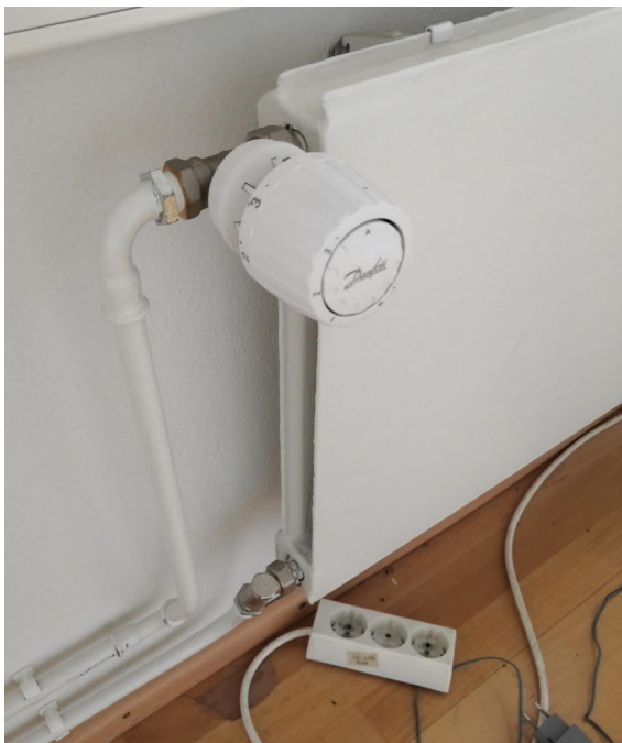
Kuva 6. Lämmityspatteri ja termostaattinen patteriventtiili. Oikealla näkyvissä vanhat ja tulpatut lämmityspattereiden kytkentäjohtojen läpivientipaikat lattiapinnassa.
